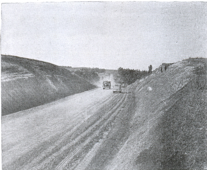
Candelária-Camobi — Trecho recém-concluído
